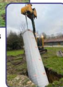
Créations de puits à eaux, Puisards...
